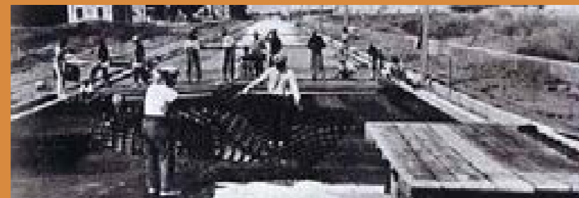
Si stende la rete metallica per la piattaforma ad uso militare (1934)
